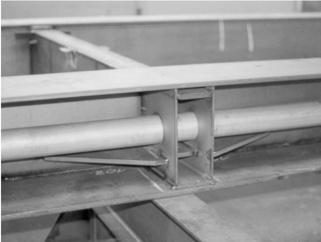
Bild 3. Knotenausbildung des Hauptträgers und Querträgers als Durchführung des Querträgers bei der Herstellung im Werk (mittig eingesetztes Edelstahlrundrohr dient zur Führung eines Stromkabels)
